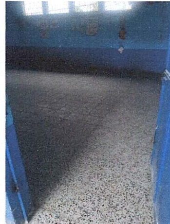
Foto 2: Piso instalado en un 100%
