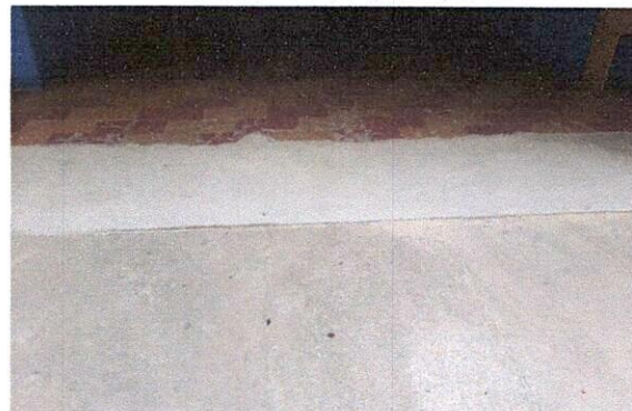
Foto 4: Elaboración de rampa en la entrada
